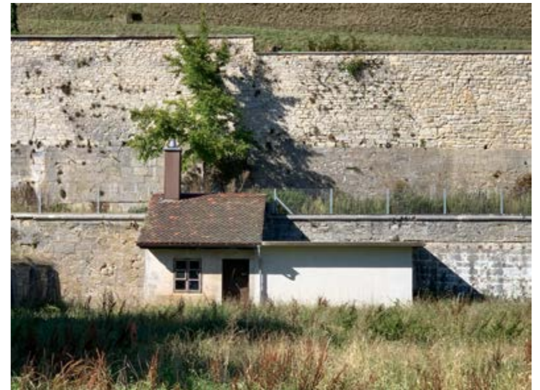
Terrassengärten des Klosters Bellelay, mit Geräteschuppen
