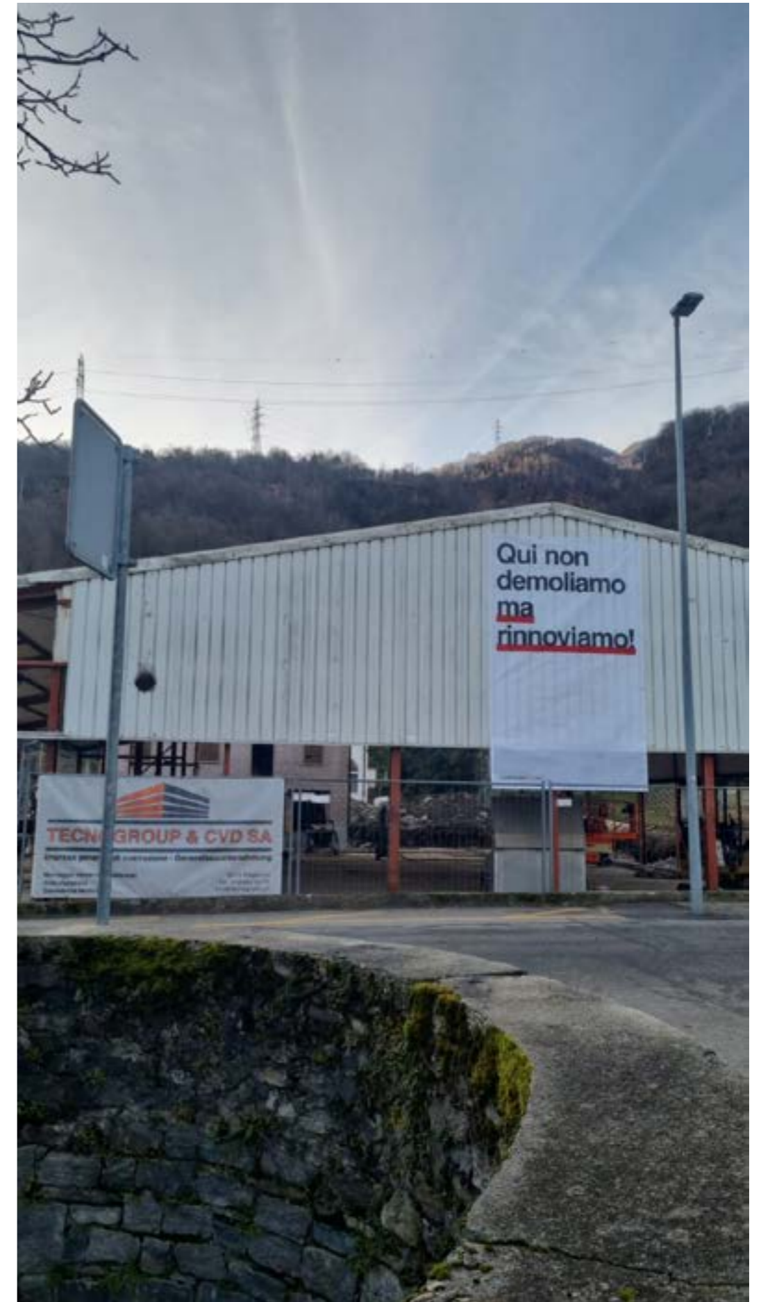
© Zanini Gozzi Sagl, Wiederverwendung einer Kegelbahn mit Verstärkung Stahlbautragwerk, Quartino TI
